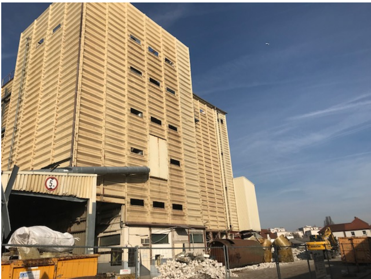
Ehemaliges HALEMA Gebäude vor Abbruch
